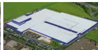
Hörmann KG Ichttershausen, Allemagne
