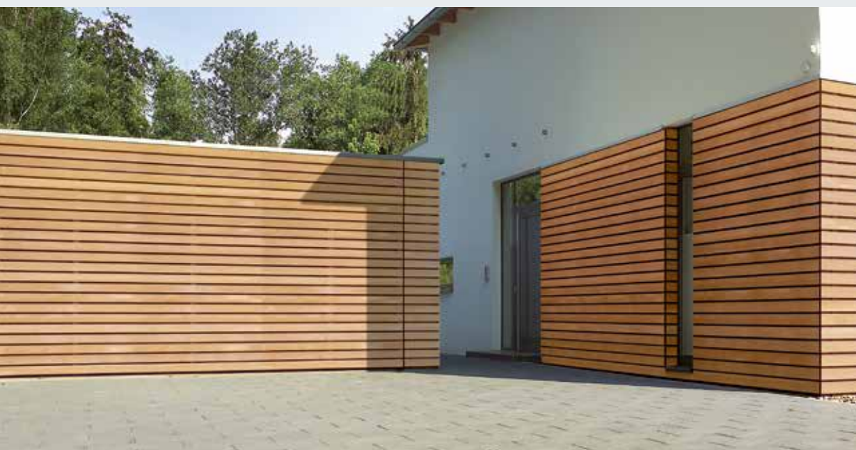
Bekleding door klant met houten panelen
